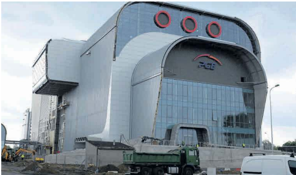
Spalarnia PGE obecnie przetwarza termicznie odpady w trybie rozruchu
