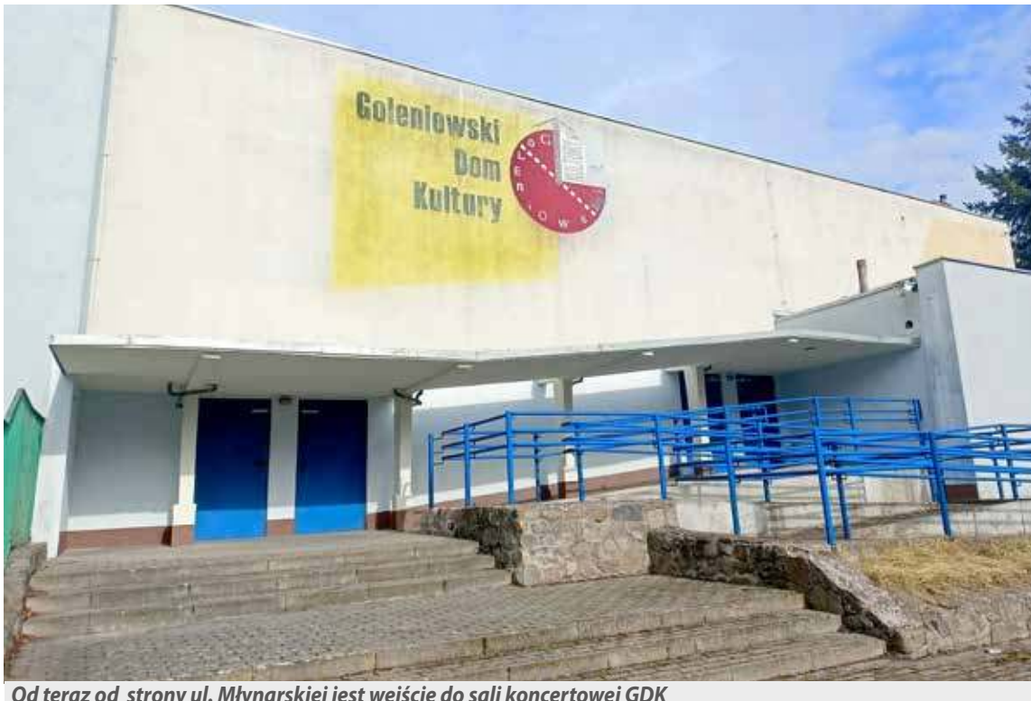
Od teraz od strony ul. Młynarskiej jest wejście do sali koncertowej GDK
