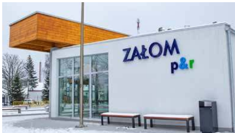
Centrum przesiadkowe w Załomiu już w grudniu było gotowe do obsługi pasażerów
