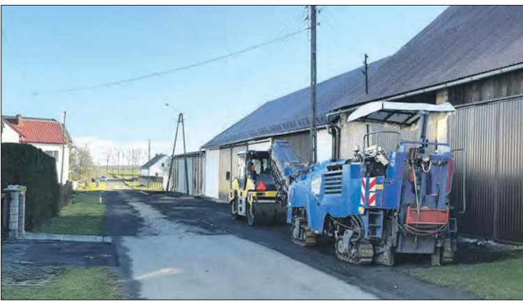
Remontowana droga gminna w Nowym Browincu
