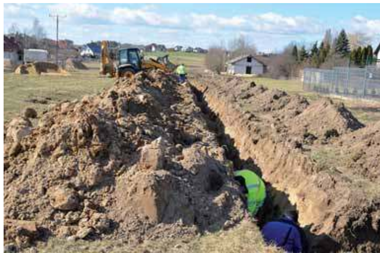
Prace przy ul. Husarskiej
