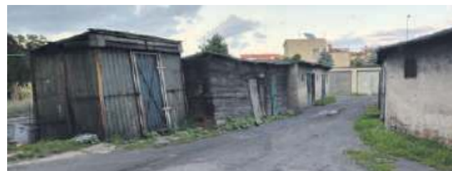
Wszystkie komórki znajdujące się na podwórku obecnie są użytkowane, ale jeżeli ich użytkownicy zrezygnują, będą rozebrane
