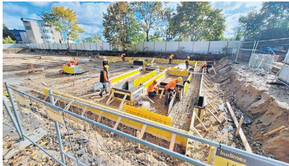
Firma Budimex prowadzi intensywne prace na placu budowy przy ulicy Fałata
