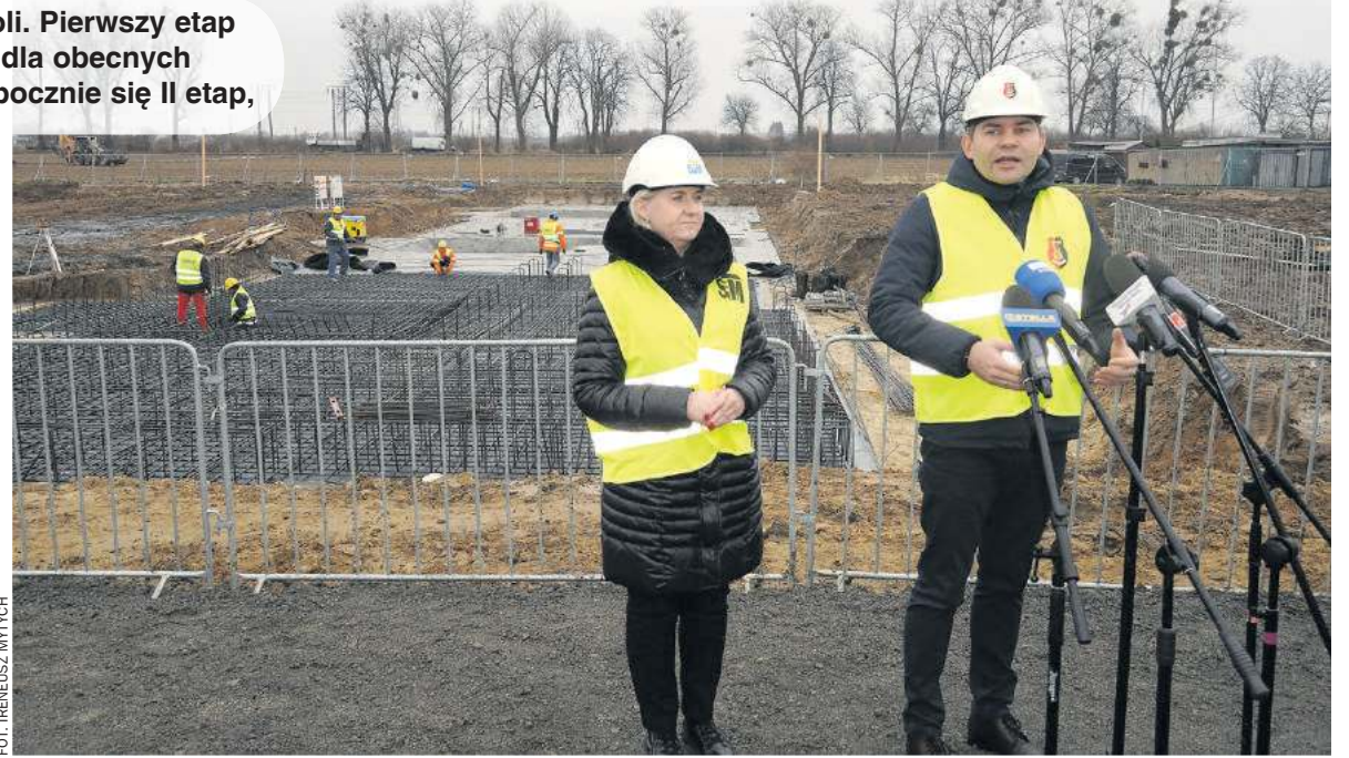
Trwa realizacja pierwszego etapu budowy osiedla Ogrodowego
