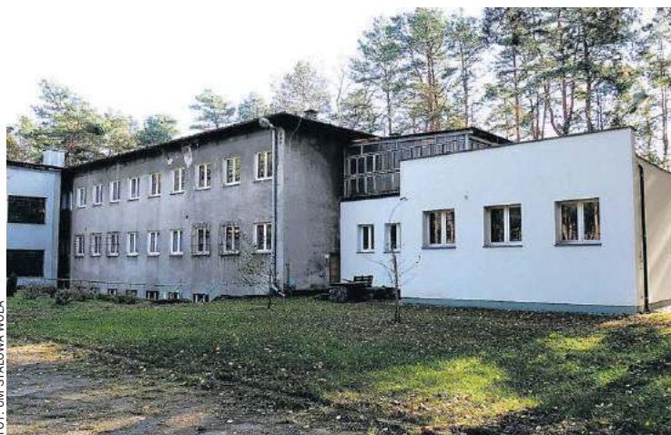
Budynek dawnego żłobka przejdzie modernizację
