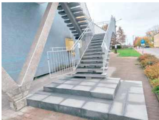
Remont schodów jest już prawie zakończony
