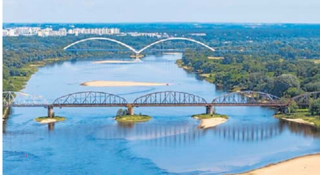
Most kolejowy i „nowy” most drogowy w Toruniu
