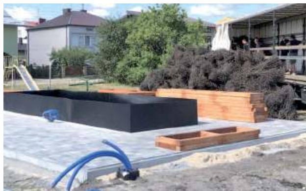
Tężnie solankowe to konstrukcje wykonane z drewna, pokryte gałązkami tarniny lub brzozy, z ukrytym w środku urządzeniem do pompowania wody. Tak wyglądała biłgorajska tężnia tuż po przywiezieniu do miasta
