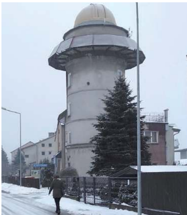
Budynek ma przejść gruntowny remont zarówno z zewnątrz (termomodernizacja), jak i w środku. Pomieszczenia zostaną dostosowane do nowych funkcji – wystawniczej i edukacyjnej – a wszystkie instalacje przejdą konserwację
