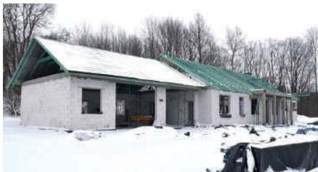
Pieniądze uzyskane ze sprzedaży działek mają umożliwić dalszą budowę nowej strażnicy OSP Klementowice, która rozpoczęła się w zeszłym roku. Budynek wymaga doprowadzenia do stanu surowego zamkniętego
