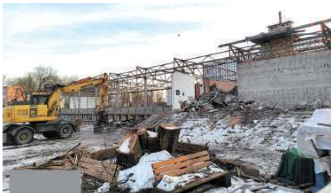
Budynek pawilonu zaczął znikać kilka tygodni przed rozprawą. Dziś niewiele z niego zostało. Czy wyrok NSA oznacza, że dalsze prace staną?
