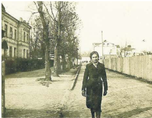
1937 rok. Po lewej budynek dawnego „Monopolu” przy ul. Orlej. Teraz jest on siedzibą zamojskiej Prokuratury Okręgowej.
