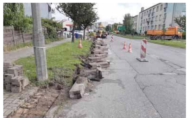
Wymiana krawężników na ul. Grzebskiego
