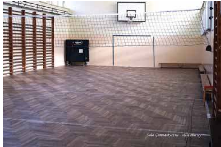
Nie tylko budynek, ale i salę gimnastyczną czeka modernizacja
