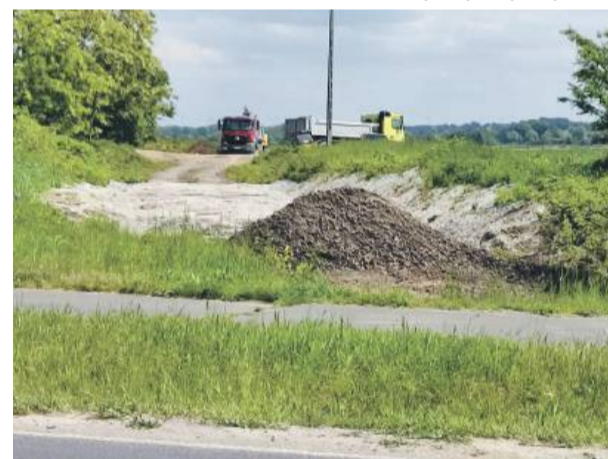
Na placu budowy ścieżki rowerowej ciągle widać pracujące ekipy. Tak wygląda to miejsce widziane z drogi Strzelin - Chociwel
