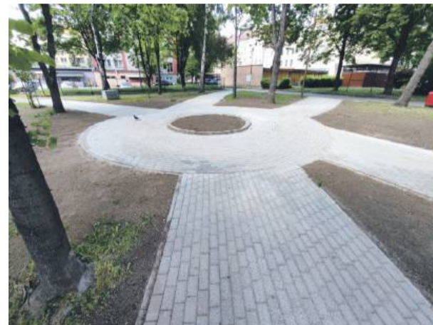
Tak wyglądają ścieżki i klomb w odnowionym skwerze
