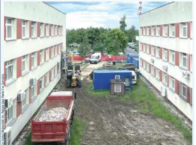
Przebudowa w zamojskim szpitalu potrwa do 2027 roku
