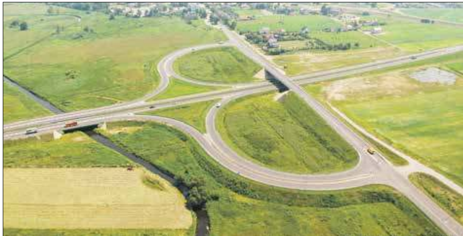
Wybudowanych ma być prawie 14 km drogi ekspresowej do końca obecnej obwodnicy miasta, gdzie na odcinku ok. 6,2 km dobudowana zostanie jeszcze druga jezdnia. Przedsięwzięcie zakłada również przebudowanie łącznic węzłów Międzyrzec Podlaski Północ oraz Międzyrzec Podlaski Południe
