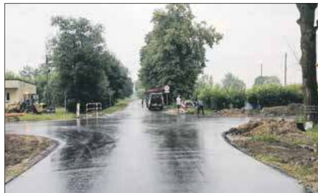
W ramach poprawy jakości dróg przebudowano drogi gminne w Kolanie, Kolonii-Kolano, Jabłoni, Gęsi oraz wybudowano nowe w Wantopolu i Dawidach
