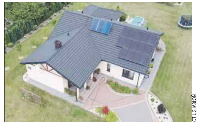
Projektem OZE objęte zostały domy jednorodzinne oraz budynki użyteczności publicznej
