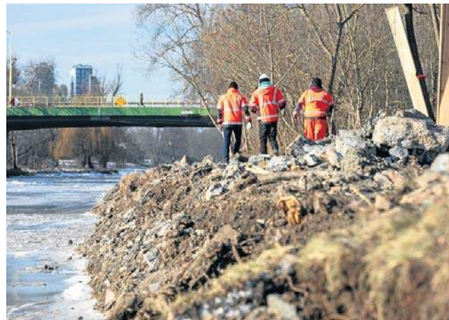
Zima nie ułatwia zadania, ale rozpoczęły się prace na bulwarach za mostem Pomorskim w kierunku ul. Żabiej
