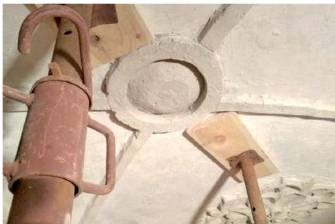
Rozety i podstemplowane sklepienia krypty
