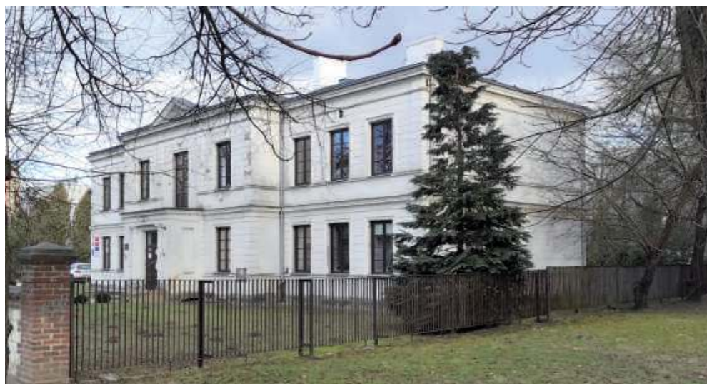
W budynku przy Al. Królewskiej mieści się m.in. Powiatowe Centrum Pomocy Rodzinie. Już wkrótce dworek przejdzie termomodernizację. Remont wyniesie około 885 tys. zł
