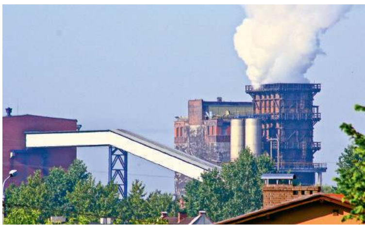
Budowa bloku energetycznego w Radlinie została ujęta w rządowym Programie dla Śląska | fot. Radlin.pl/d
