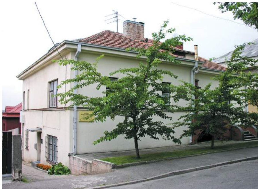
Budynek dawnego konsulatu japońskiego w Kownie.
