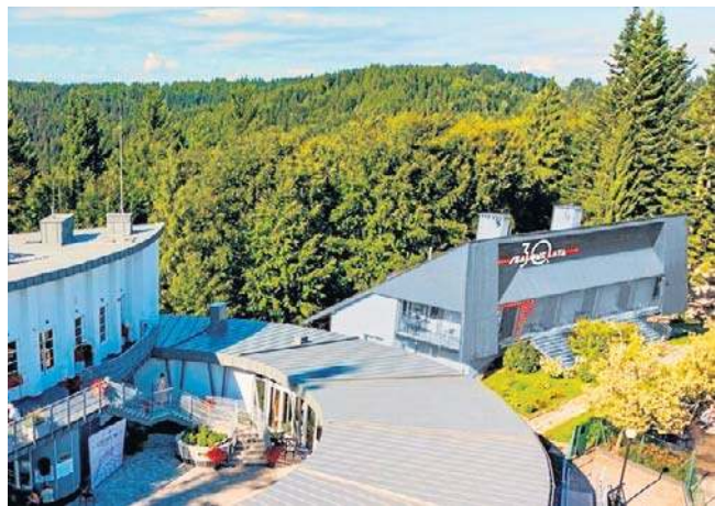
Trwają prace na Górze Parkowej. Nowa atrakcja was zaskoczy
