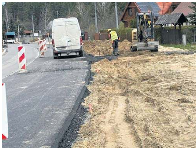
Prace prowadzone są na całym odcinku drogi
