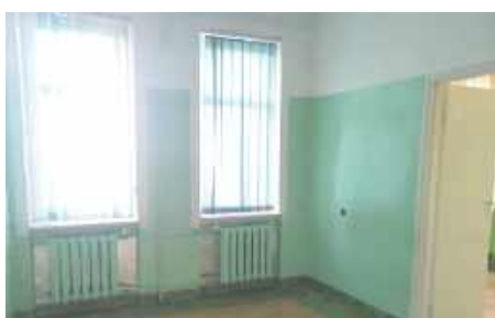
Sala chorych przed remontem
