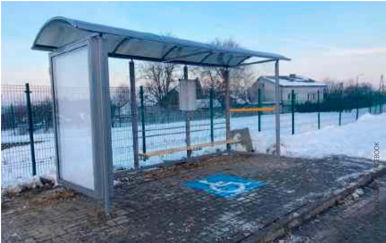
Nowa wiata przystankowa i jej ustawienie kosztowało nieco ponad 6 tys. zł.
