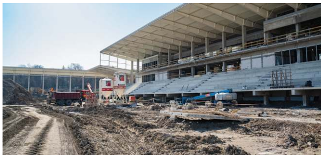
Konstrukcja pnie się w górę, a prace wyraźnie przyspieszyły wraz z nadejściem wiosny.
