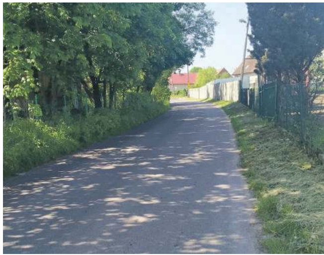
Ulica w Wielkiej Lipie prowadząca w kierunku Osoli. Brak chodnika sprawia, że mieszkańcy muszą iść jezdnią.
