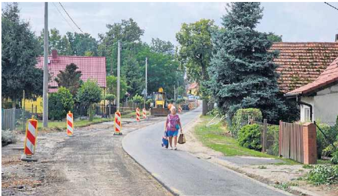
Całą wieś rozkopana, więc piesi i zmotoryzowani muszą dzielić jakoś jedną, wąską nitkę drogi...
