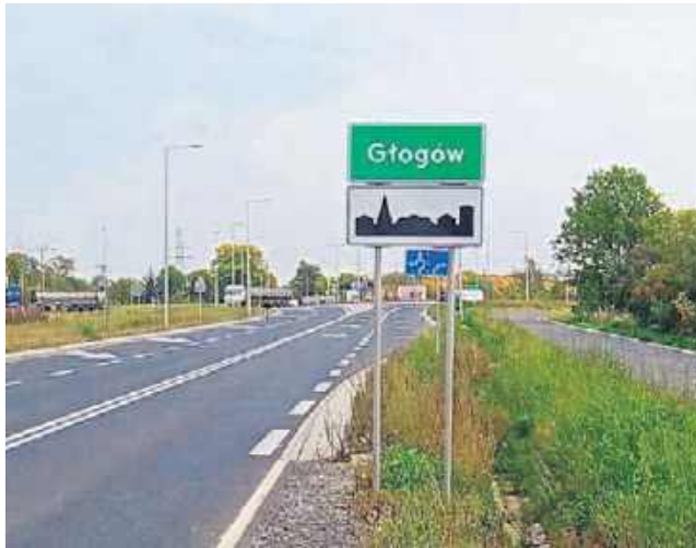
Co dalej z obwodnicą Głogowa? Inwestycja nadal nie uzyskała pozwolenia na budowę
