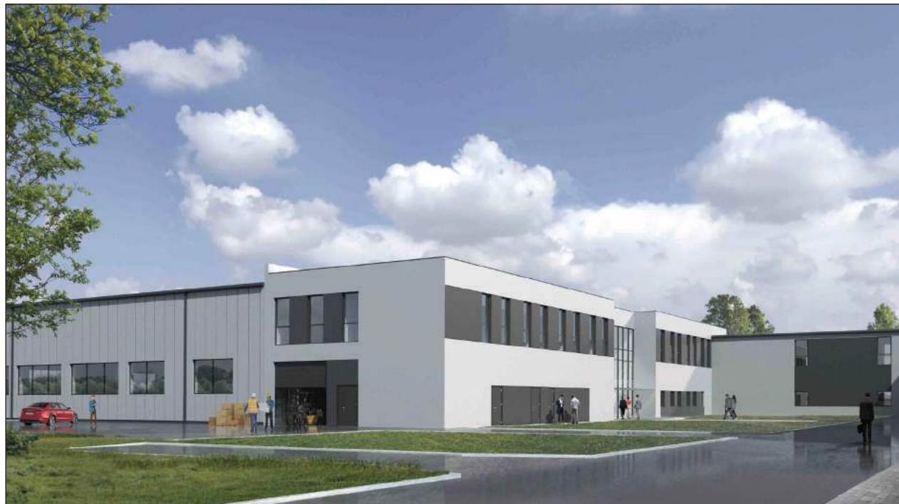
Centrum Produkcji Struktur Kompozytowych w Wojskowych Zakładach Lotniczych w Dęblinie zatrudni 20 pracowników. Budowa zakładu zakończy się w 2021 roku
