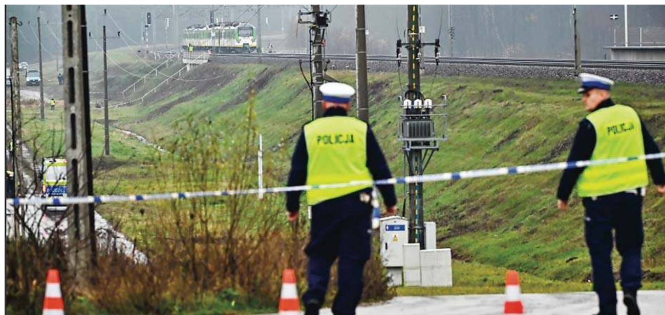
Działania służb przy zniszczonym fragmencie torowiska na trasie Dęblin-Warszawa przy stacji kolejowej w okolicy miejscowości Mika
