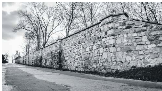
Mur przy ul. Dworskiej
