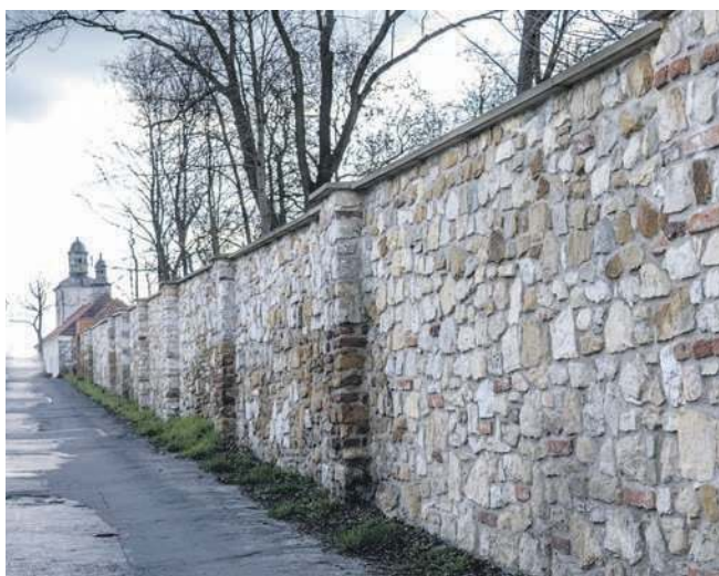
Odnowiony kamienny mur biegnący wzdłuż ulicy Dworskiej
