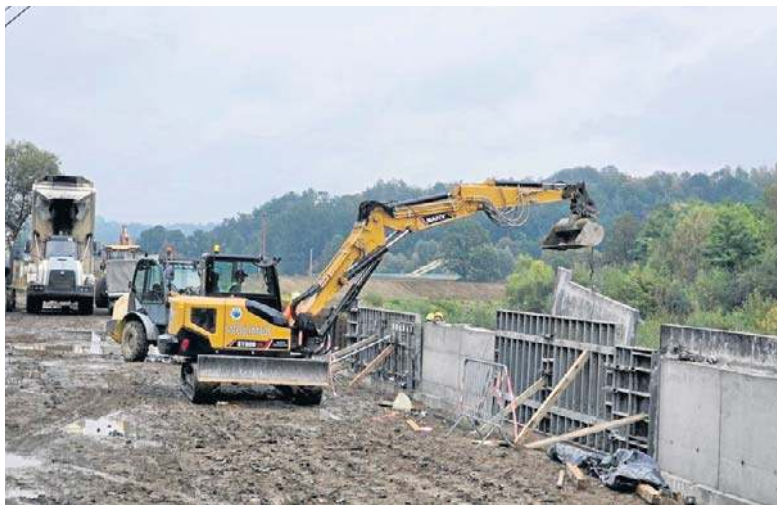
Trwa budowa wałów przeciwpowodziowych na rzece Stradomka
