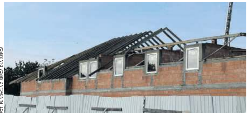
Warunki pogodowe chwilowo wstrzymały prace przy dachu hospicjum
