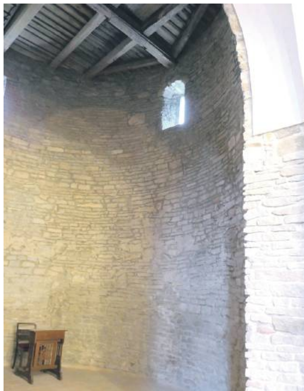
W ramach inwestycji wykonane zostaną dębowe schody w najstarszej części Rotundy św. Gotarda
