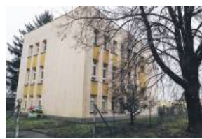
W bloku przy ul. Skawińskiej nie ma centralnego ogrzewania
