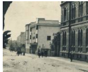
Kino Capitol, przełom lat 30 i 40 XX wieku. Foto. arch. ZB. Kazimierowicz
