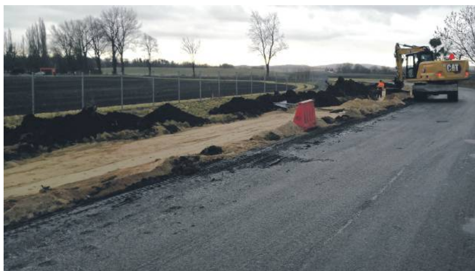
W ubiegłym tygodniu przy drodze relacji Kondratowice – Prusy rozpoczęła się długo wyczekiwana inwestycja
