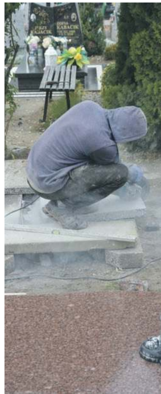
Prace zaczęły się od demontażu poprzedniego pomnika
