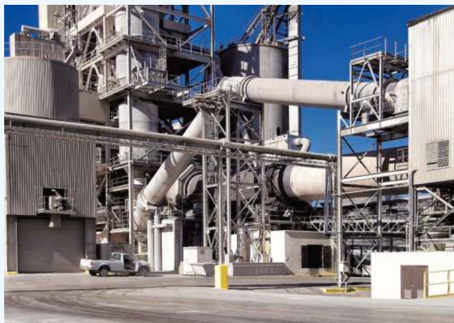
Fragment instalacji zwykłej cementowni
