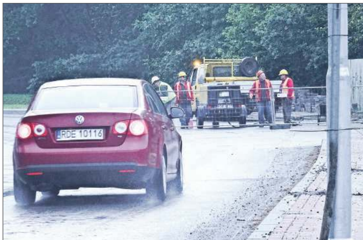
Na Kwiatkowskiego wciąż jeszcze trwają prace.
