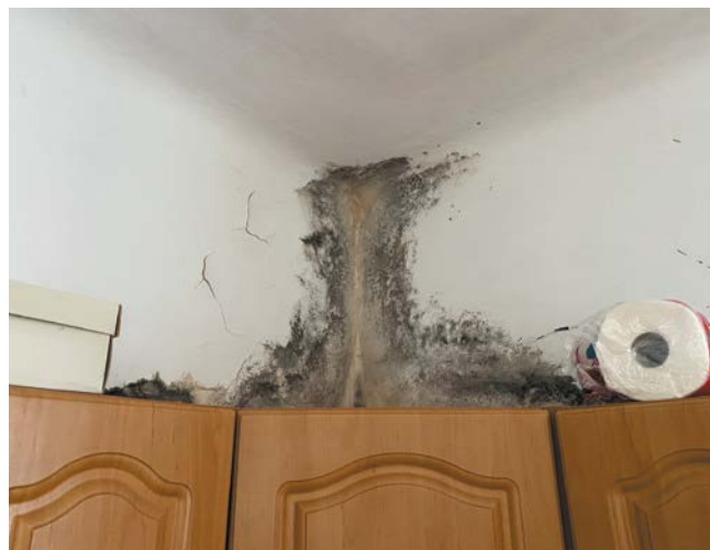
FOT. 1 Ekstremalne porażenie grzybami pleśniowymi; fot.: autor
