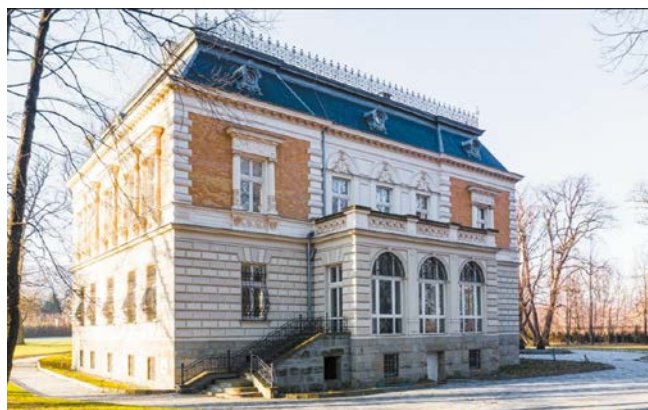
FOT. Analizowany obiekt w stanie pierwotnym [19]
