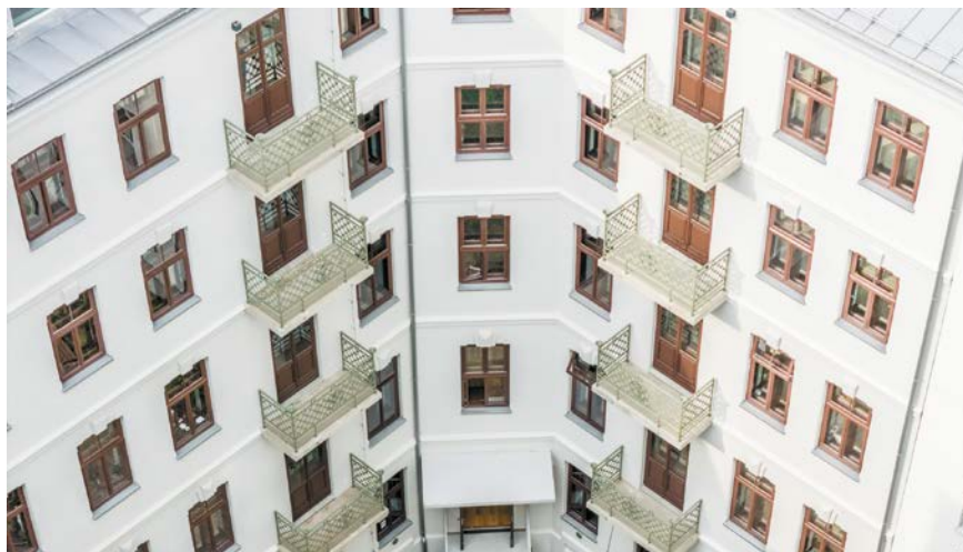
FOT. 1 Zabytkowa kamienica, ul. Konopacka w Warszawie
