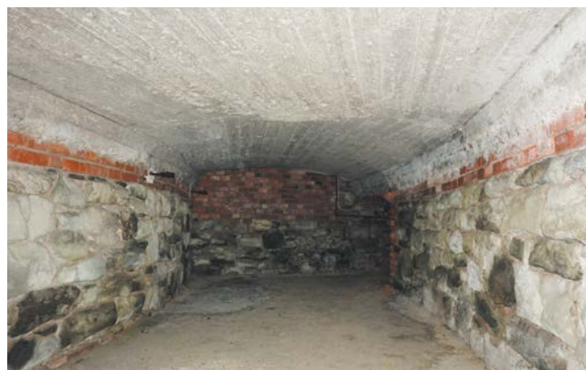
FOT. 1 Widok ścian murowanych na poziomie -2; fot.: Zygmunt Matkowski
