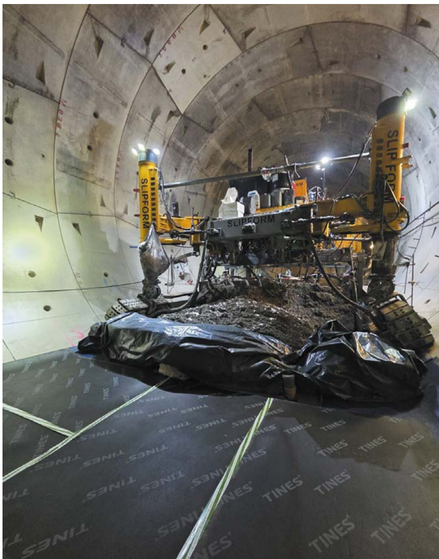
Dobrym przykładem jest budowa stacji Łódź Fabryczna wraz z całym układem torowym, gdzie już na etapie przygotowania inwestycji uwzględniono kompleksowe analizy; fot.: TINES
