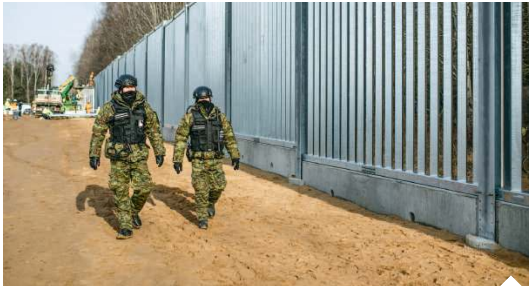
Zapora będzie wyposażona m.in. w czujniki, które ostrzegą funkcjonariuszy Straży Granicznej o tworzeniu podkopów i uszkodzeń | fot. Michał Kość/Forum
