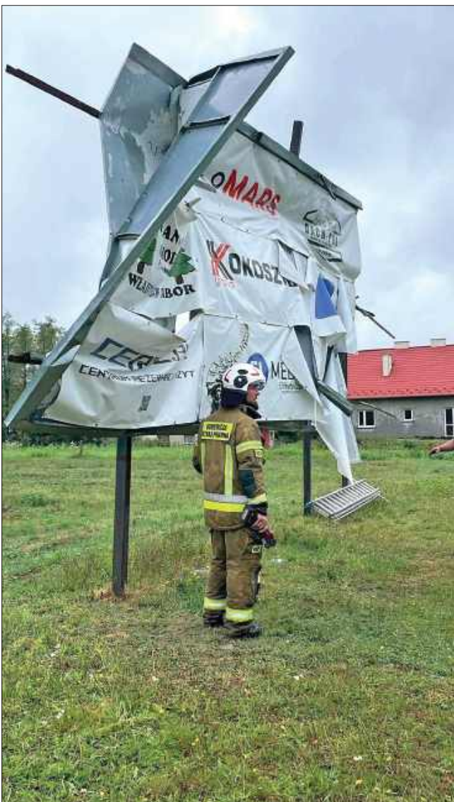
Stadion Janovii uległ poważnym zniszczeniom.
