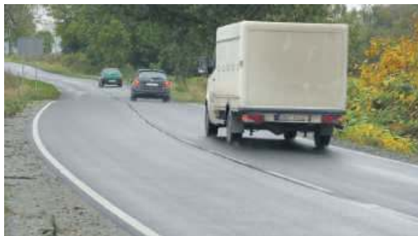
Niewątpliwie jedną z ważniejszych inwestycji na drogach powiatowych był remont odcinków na trasie Strzelin - Jegłowa
