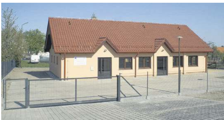
Tak wygląda wybudowana w Gościęcicach świetlica, o której pisaliśmy kilka tygodni temu. To jedna z większych inwestycji zrealizowanych w tym roku. Foto UMIG Strzelin
