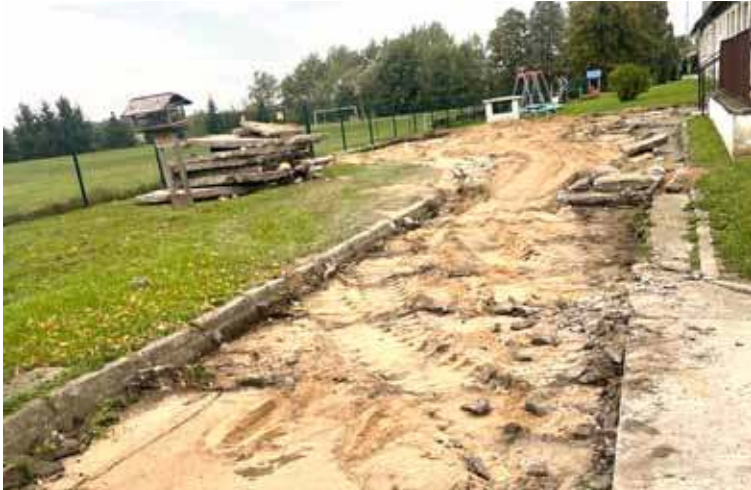
Prace prowadzone są pod SP w Dębicach (fot. Gm. Maszewo).
