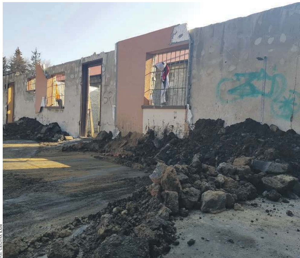
Tak obecnie wygląda z zewnątrz modernizowana świetlica w Gromcu
