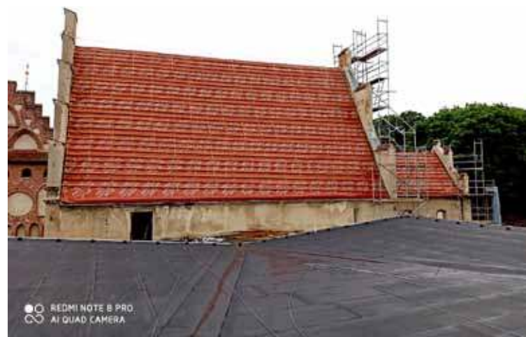
Trwają roboty na dachu zabytkowej kamienicy
