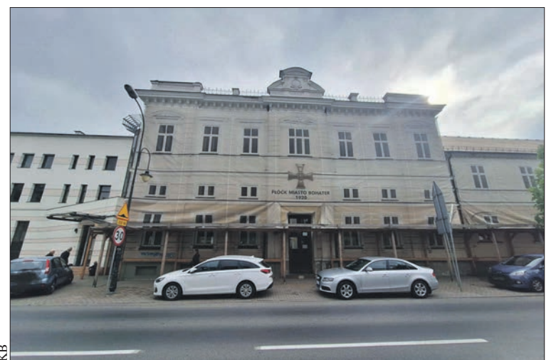
Budynki od strony ul. Kolegialnej
