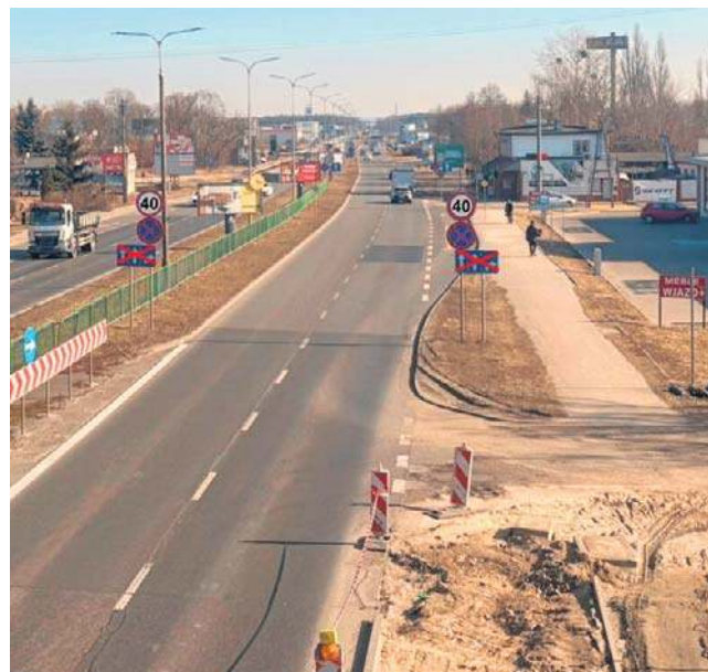
Wykonawca powrócił na plac budowy, co wiąże się z nowymi utrudnieniami w ruchu
