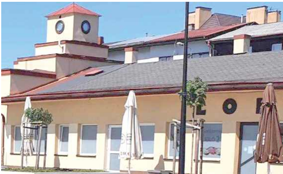
Wykonawca ma czas na wykonanie prac budowlanych do 1 czerwca 2025 roku
